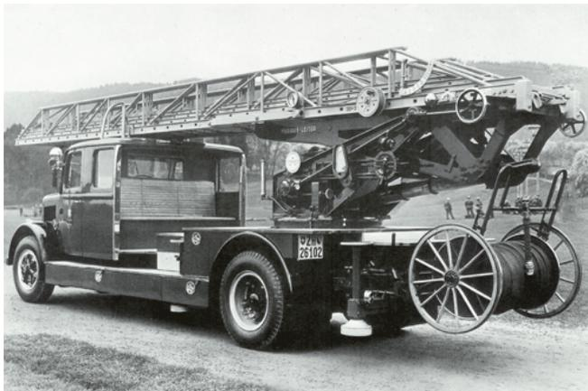
Die alte Autodrehleiter konnte 1962 durch ein neueres Modell ersetzt werden. Die 30 Meter Saurer/Magirus-Leiter mit Jahrgang 1939, im Gegensatz zur alten Holzleiter eine Ganzstahlkonstruktion, wurde aus dem Fahrzeugpark der Berufsfeuerwehr der Stadt Zürich übernommen.
